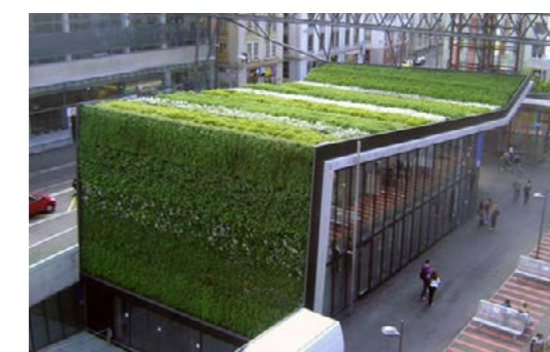
Toit végétal_ Suisse
